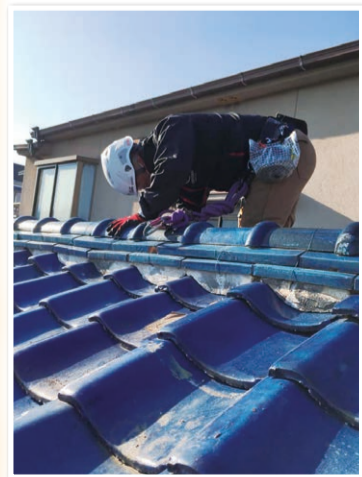
として自分達で屋根に登り、ブルーシートをかぶせ、土のう袋を積み雨よけを行いました。不安定な足場での作業で事故に繋がる恐れもありました。
