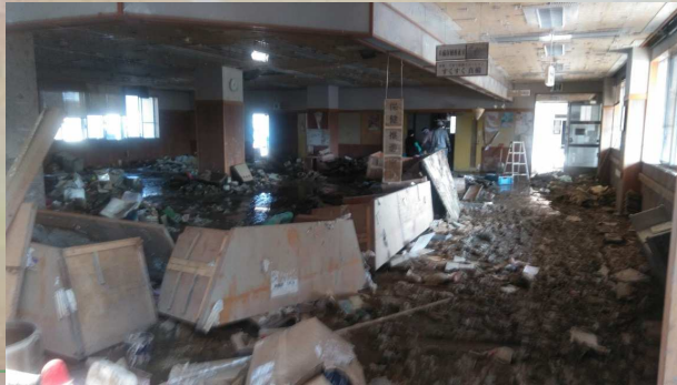
201807倉敷市役所真備支所 (H30年7月豪雨)
