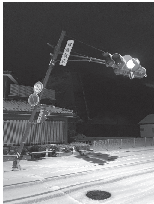
（写真左）根こそぎなぎ倒された電柱。電線が垂れさがっている （写真右）根元から曲がって傾いている交通信号機。道路には積雪がある
