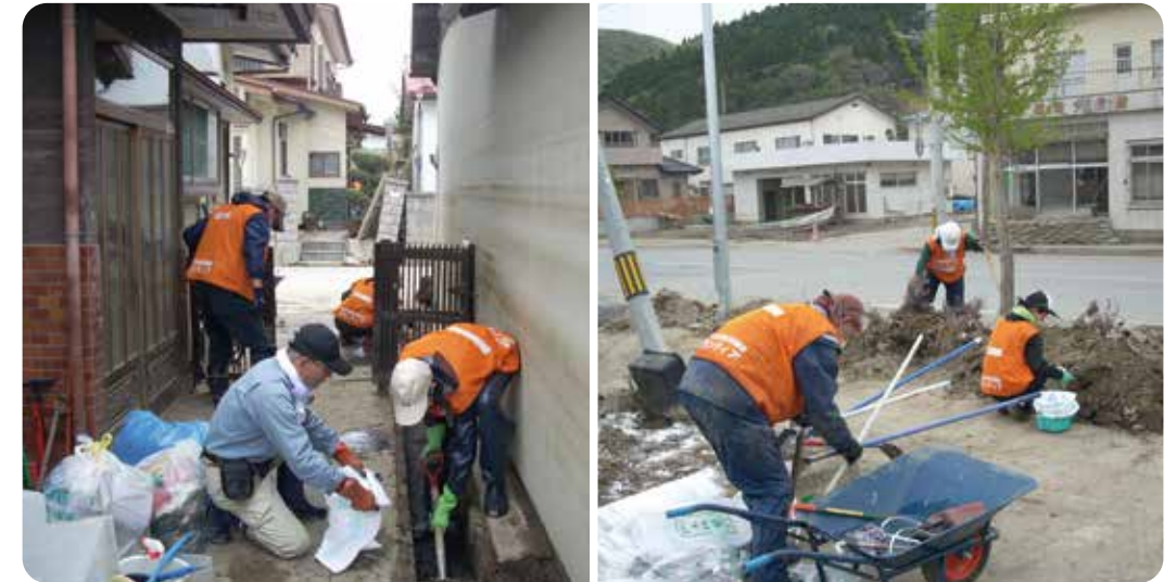
2011年 宮城県石巻市での屋外の片付けの様子
